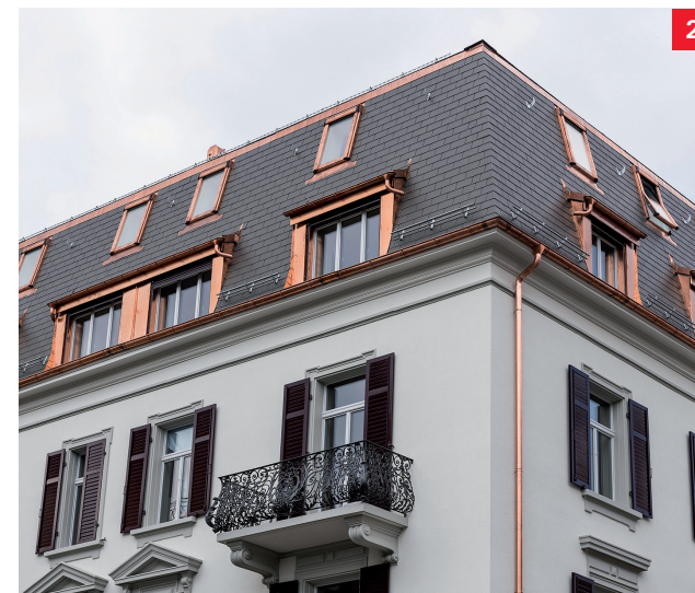
2 Acoperire pentru ferestre de acoperiș din cupru pentru a spori designul unic al fațadei
