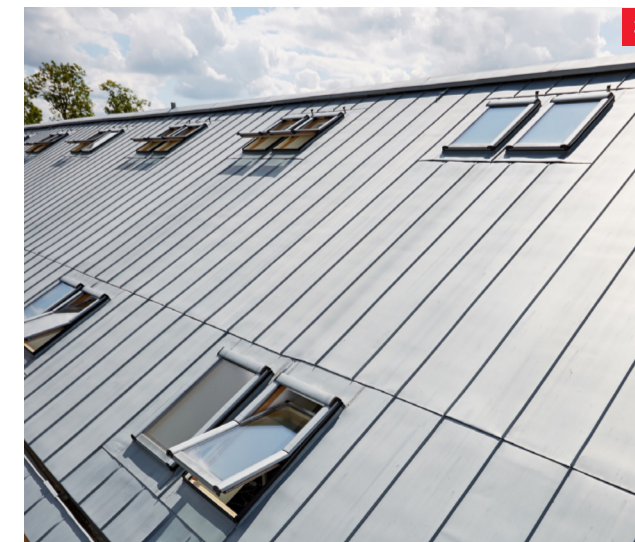
3 Integrarea perfectă a ferestrei și a acoperișului datorită învelișului din zinc titan
